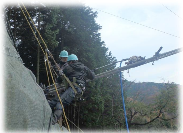
ソイルネイル挿入 ウインチ使用
