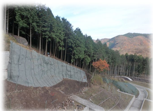
人力による法面保護工完成
