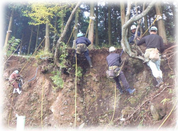
人力法面整形 オーバーハング除去
