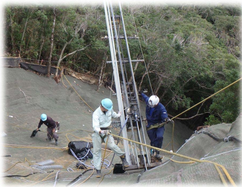
ソイルネイル挿入
