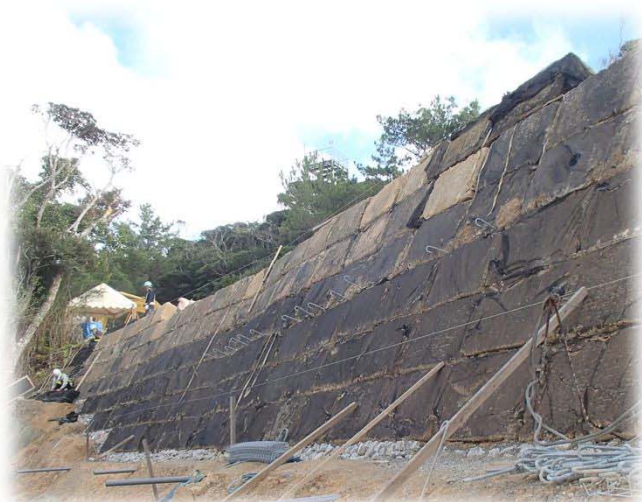
圧縮土のう積による仮土留め
