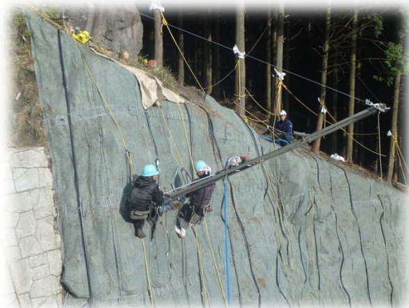
ウインチ使用人力施工
