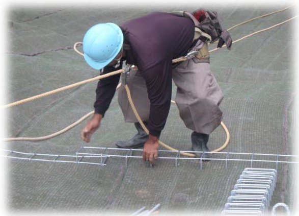
ベルトフレーム設置
