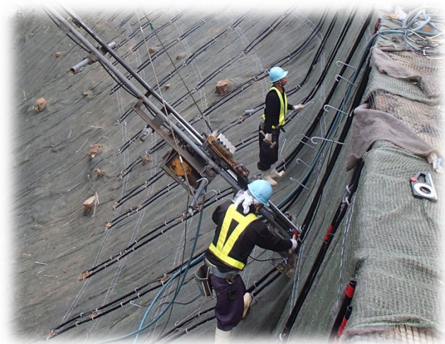
ソイルネイル挿入状況
