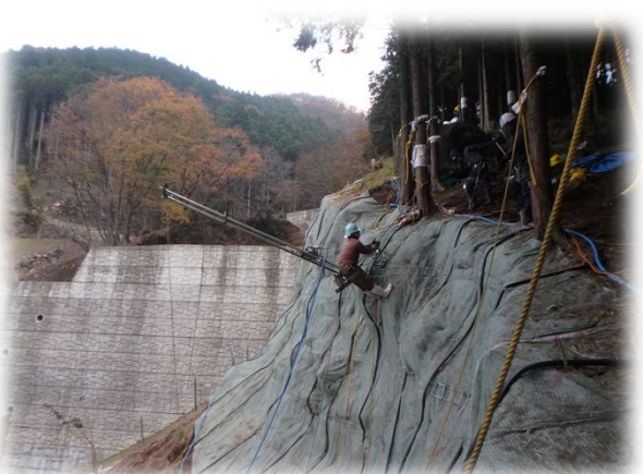
ソイルネイル挿入 ウインチ使用
