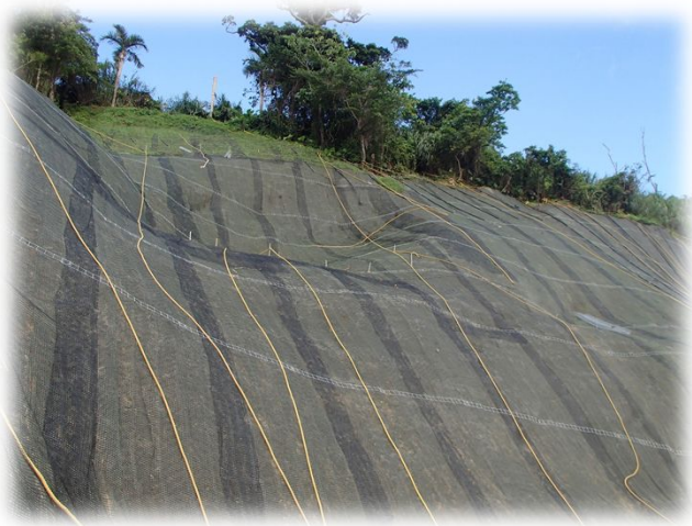
高強度植生マット、ベルトフレーム設置
