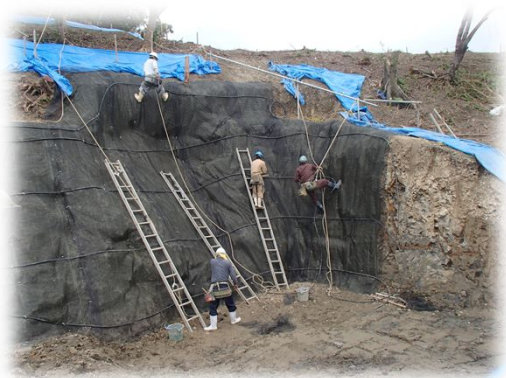
高強度マット設置
