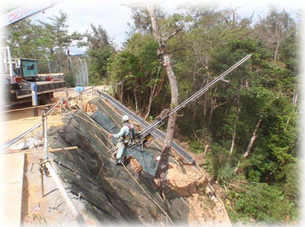
小型移動式クレーン使用
