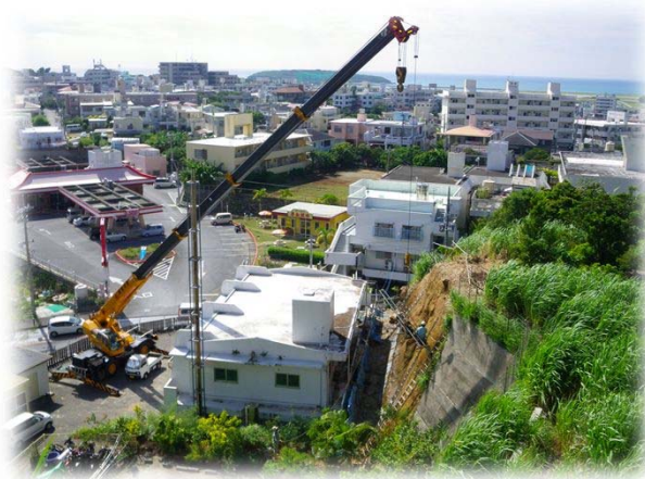
25tクレーン使用
