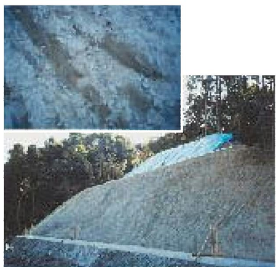
施工前（青粘土）
