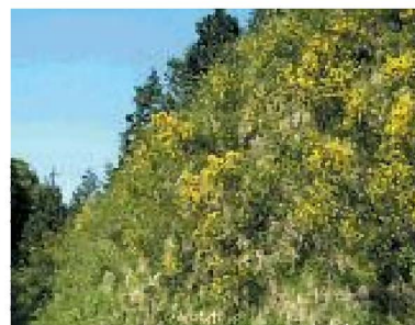
施工後5年1ヶ月
