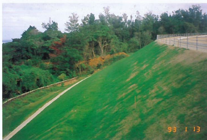
県道漢那-松田線施工現場
