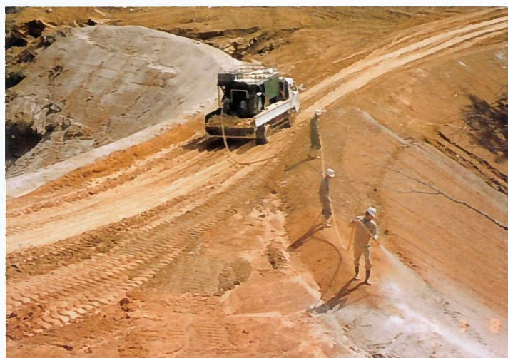
海邦カントリークラブ 赤土流出防止工事
