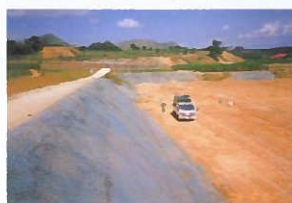
金武町伊芸土地改良区法面保護工事
