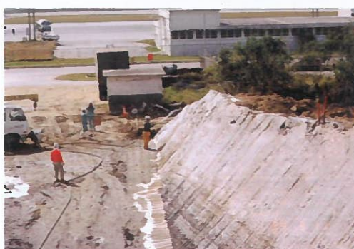
那覇駐屯地 赤土流出防止工事
